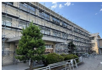
図1：足場に囲まれた校舎
