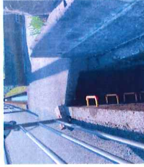
水路からの脱出用ステップ設置
