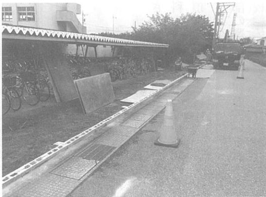
<地震対策のブロック塀改修の様子 (H30.9.13)>
