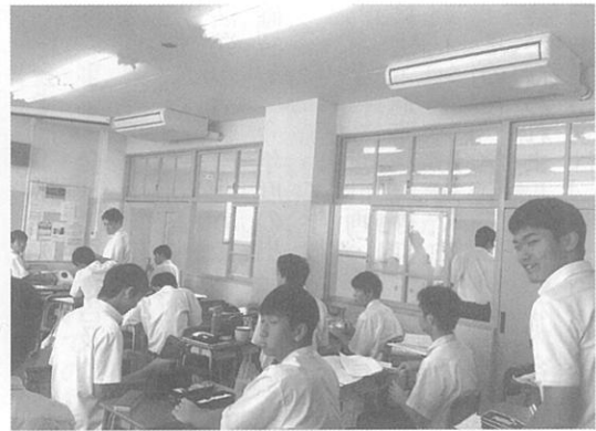
<各教室の空調設備 (H30.9.13)>
