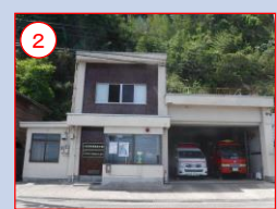
七鹿消防本部東部分遣所
