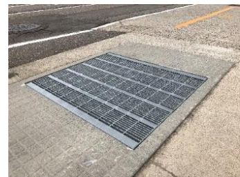
降雨時のグレーチング
