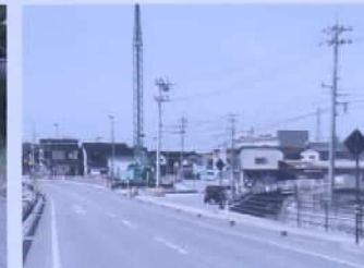
道路建設工事現場
