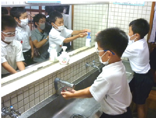
自動水栓設置
