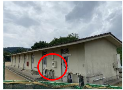
鳴和坂部室棟 AED
