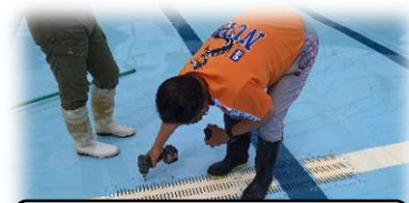
排水口もしっかり安全点検
