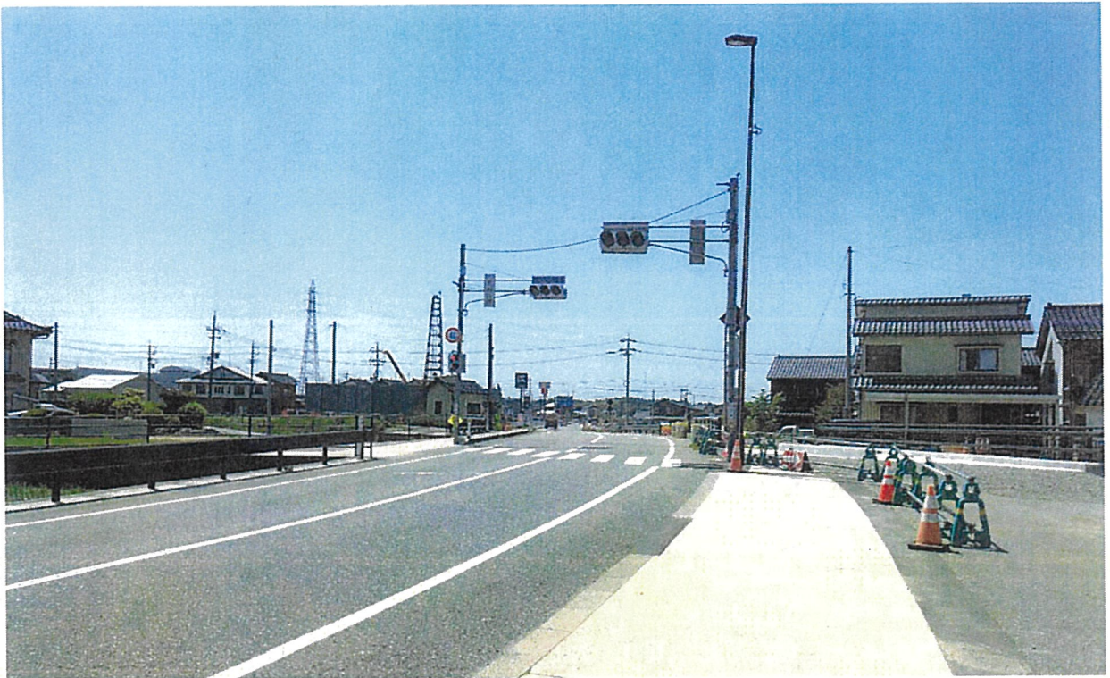
既設信号写真（城山側から望む）
