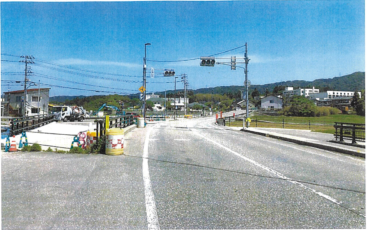
既設信号写真（国道側から望む）
