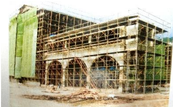
<建設工事中の新校舎> (H4年)
